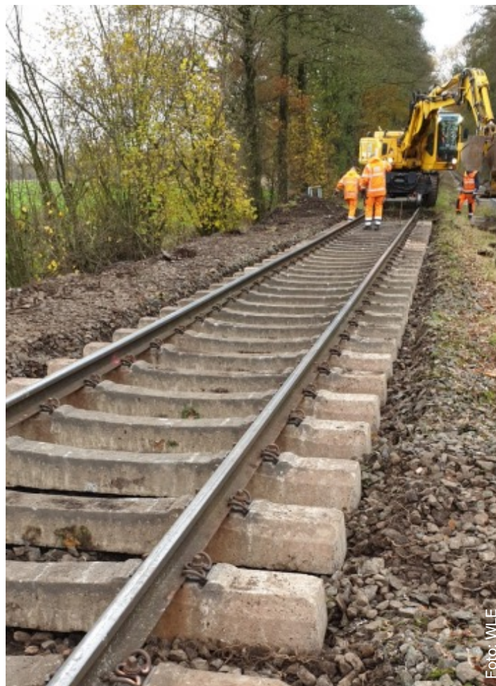
Gleisumbauarbeiten im Zuge des Oberbauprogramms.
