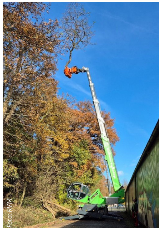
Fällarbeiten am Bahndamm
